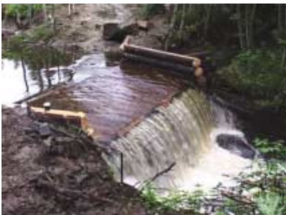
Figur 3. Korttidssperre i sidevassdraget Stor-Augla i Steinkjervassdraget brukt i forbindelse med seksjonert rotenonbehandling av vassdraget i 2002. Foto: VESO
