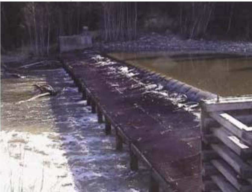
Figur 2. Langtidssperre bygget i elva Figga. Sperra har fungert som oppgangshinder i mange år. Foto: H. P. Fjeldstad
